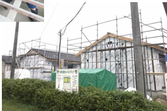
建築中の仮設住宅
